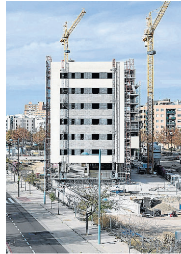
Obras en el barrio de Jesús. O. DUCH
